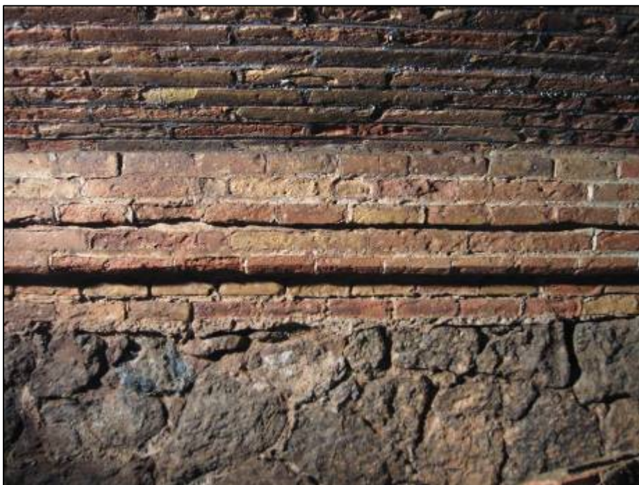
Detall de l'arrencament de la volta( construïda de maons) amb el basament del pont construït de pedres ben tallades i polides.
