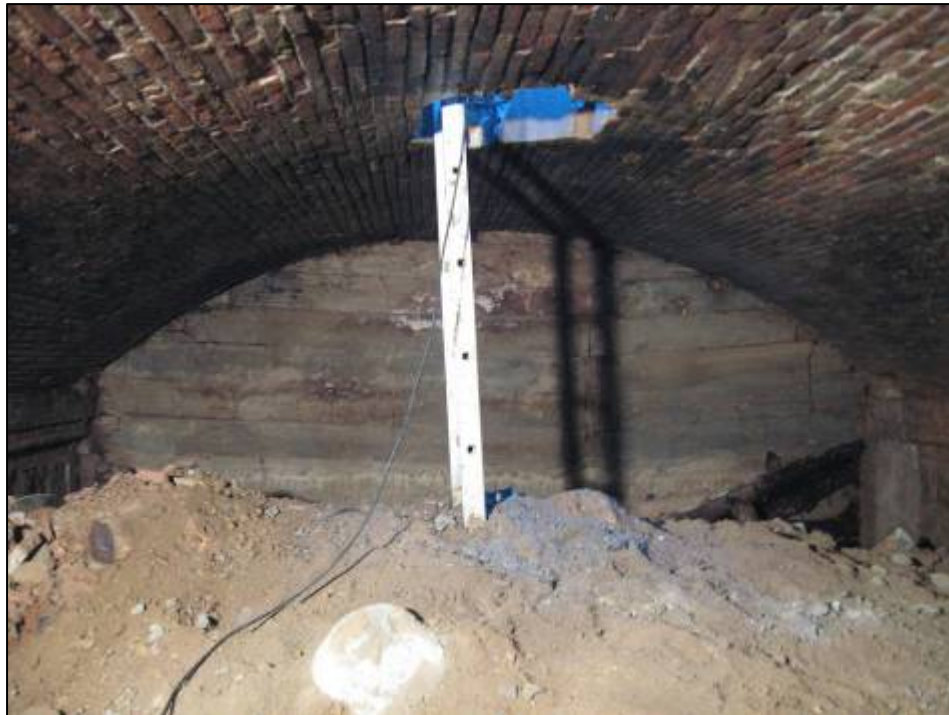
L'interior del pont, amb la paret de formigó ( UE 104) del fons.
