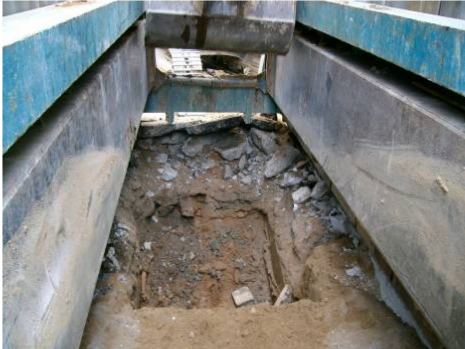
U.E.S: 200 i 201, paviment i capa de sauló.
