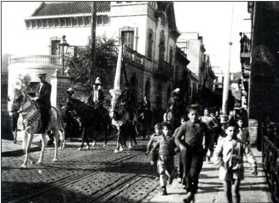
El pont des de dalt, mirant cap al carrer Fulton, el dia dels tres Tombs. ( Foto cedida pel tiet del Sr. Enrique Gil, servei de control d'Obres).
