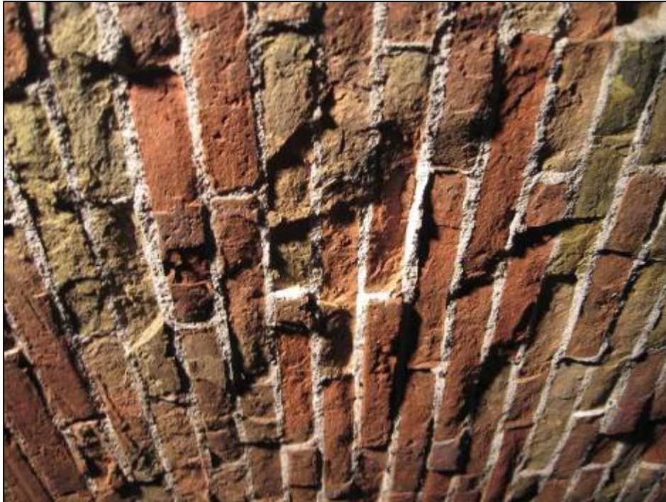
Detall de la construcció de la volta de la part interior del pont, del tipus plec de llibre.
