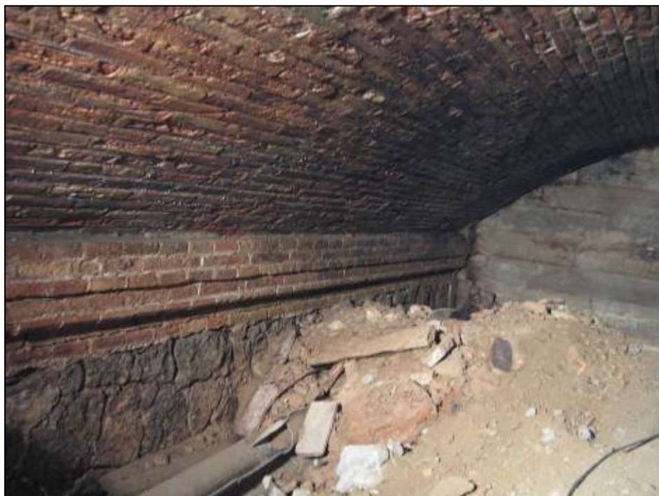
Detall de la paret i la volta del pont. Al fons es veu tapiat, amb formigó ( UE 104), del moment que perd la funció de pont, i queda totalment cobert pel nou nivell carrer.
