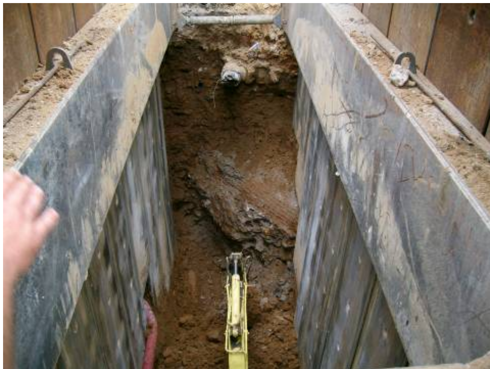
Final de la rasa amb el col·lector antic del carrer d'Horta, al fons.
