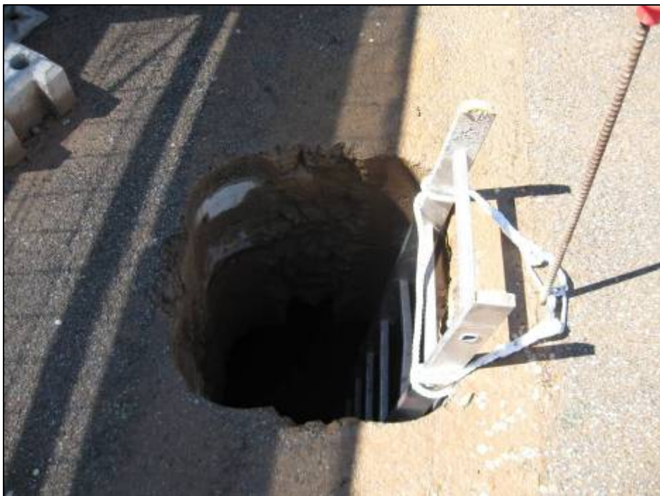
La perforació que es va realitzar el dia 27 d'Abril, per on s'accedia a dins la boca del pont.
