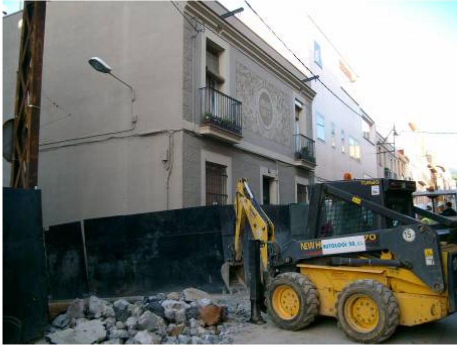
Inici de l'excavació
